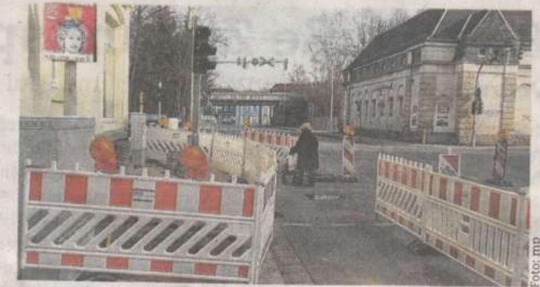
Der Gehweg an der Breithauptstraße bleibt noch bis Ende kommender Woche Baustelle.
