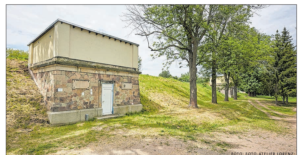
TRINKWASSERBEHÄLTER WIE DIESER SIND BESTANDTEIL UNSERER TRINKWASSERVERSORGUNG.
