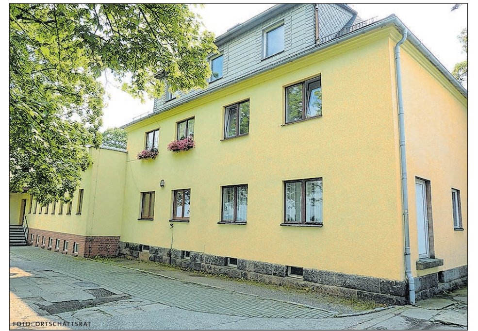
ALS STADTTEILZENTRUM IST DAS SANIERTE TURNERHEIM KÜNFTIG AUCH SITZ DES ORTSCHAFTSRATES CAINDORF.
