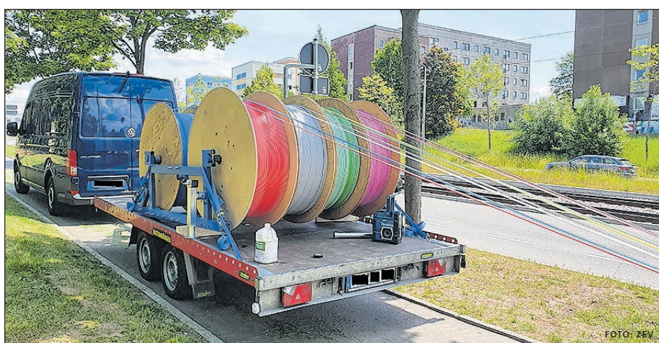
DIE ZEV ZIEHT ZURZEIT DIE MIKROROHRE FÜR DIE GLASFASERN DER ZWICKAUER SCHULEN EIN.
