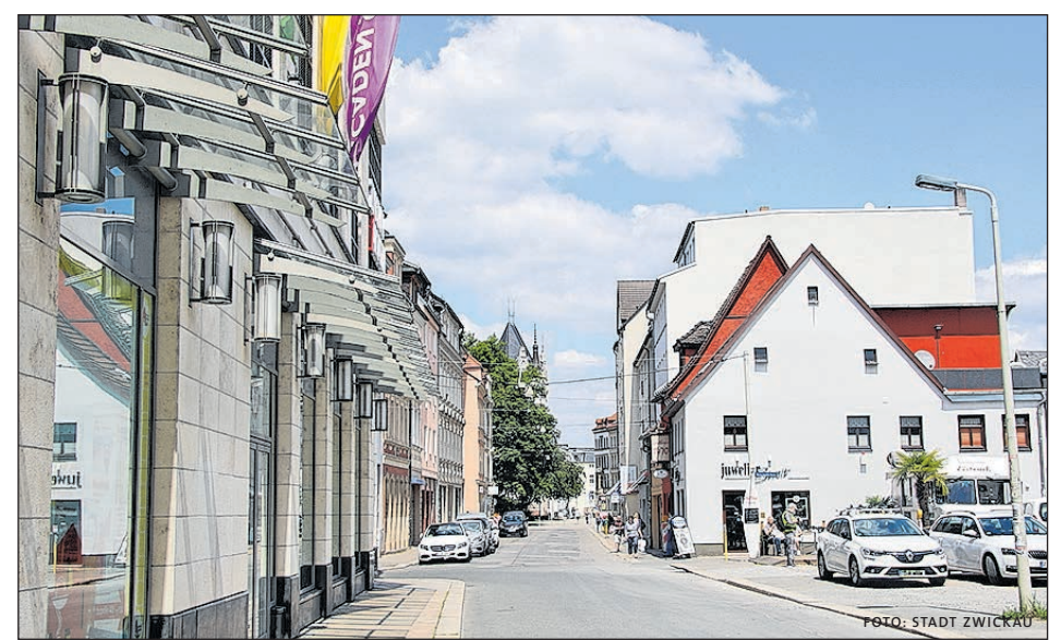
2021 SOLL DIE MARIENSTRASSE IM ERSTEN BAUABSCHNITT ZWISCHEN DEM SCHUMANNPLATZ UND DER LIEFERZUFABRT FÜR DIE ZWICKAU-ARCADEN NEUGESTALTET WERDEN. AUCH DAS ROSENGÄSSCHEN ZWISCHEN MARIENSTRASSE UND HAUPTSTRASSE WIRD ERNEUERT.
