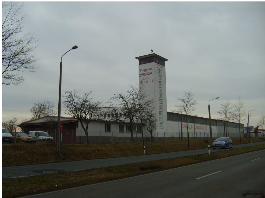
Bild 6: Gebäude Reichenbacher Straße 131 (Immissionsorte IO 10 bis IO 11). Blickrichtung Südwest.
