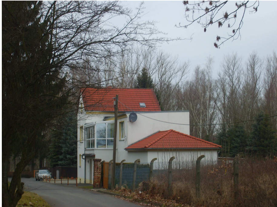
Bild 9: Wohnhaus Reichenbacher Straße 166 (Immissionsort IO 15). Blickrichtung Nord.
