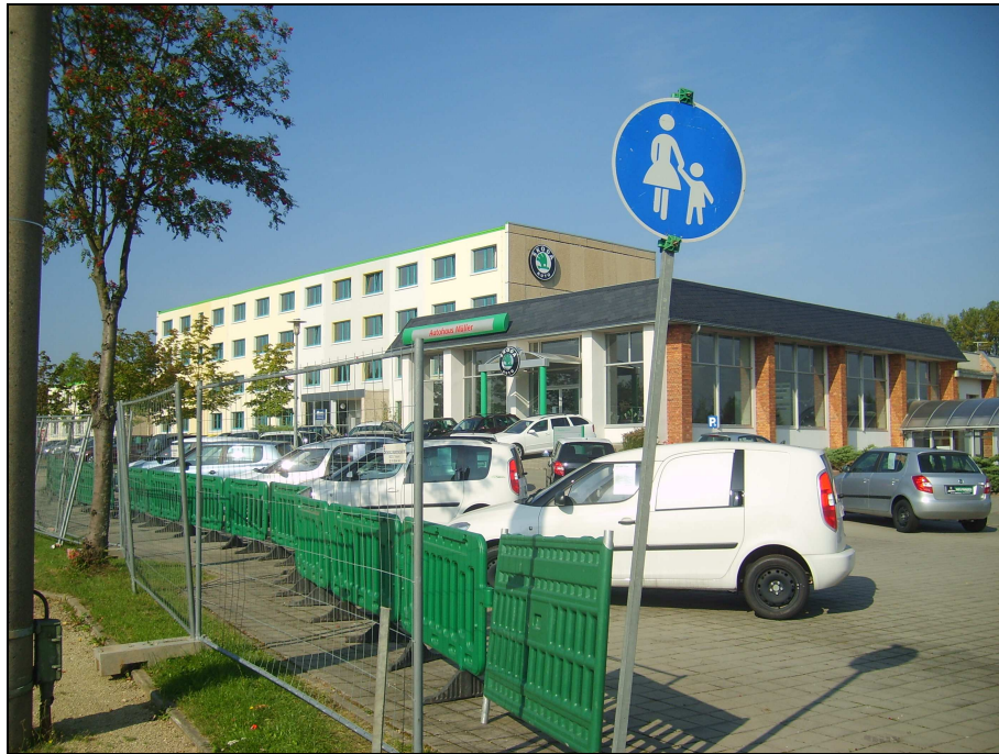
Bild 7: Bürogebäude Reichenbacher Straße 158 (Immissionsorte IO 12 und IO 13). Blickrichtung West.
